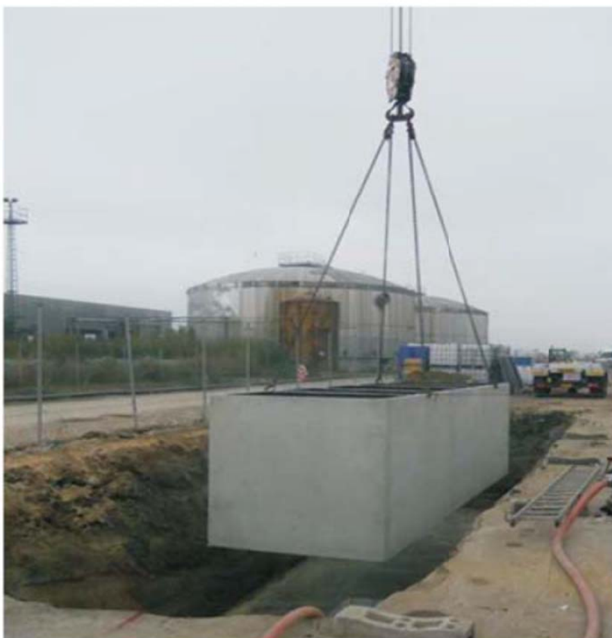
Fase di alloggiamento della vasca nello scavo
