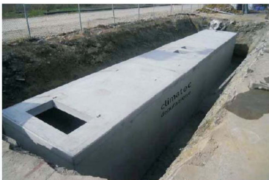
Posizionamento finale della vasca
