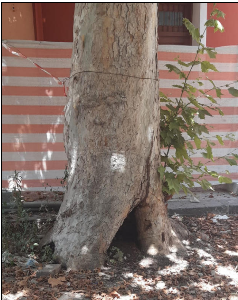
Particolare del colletto e di una porzione del fusto
